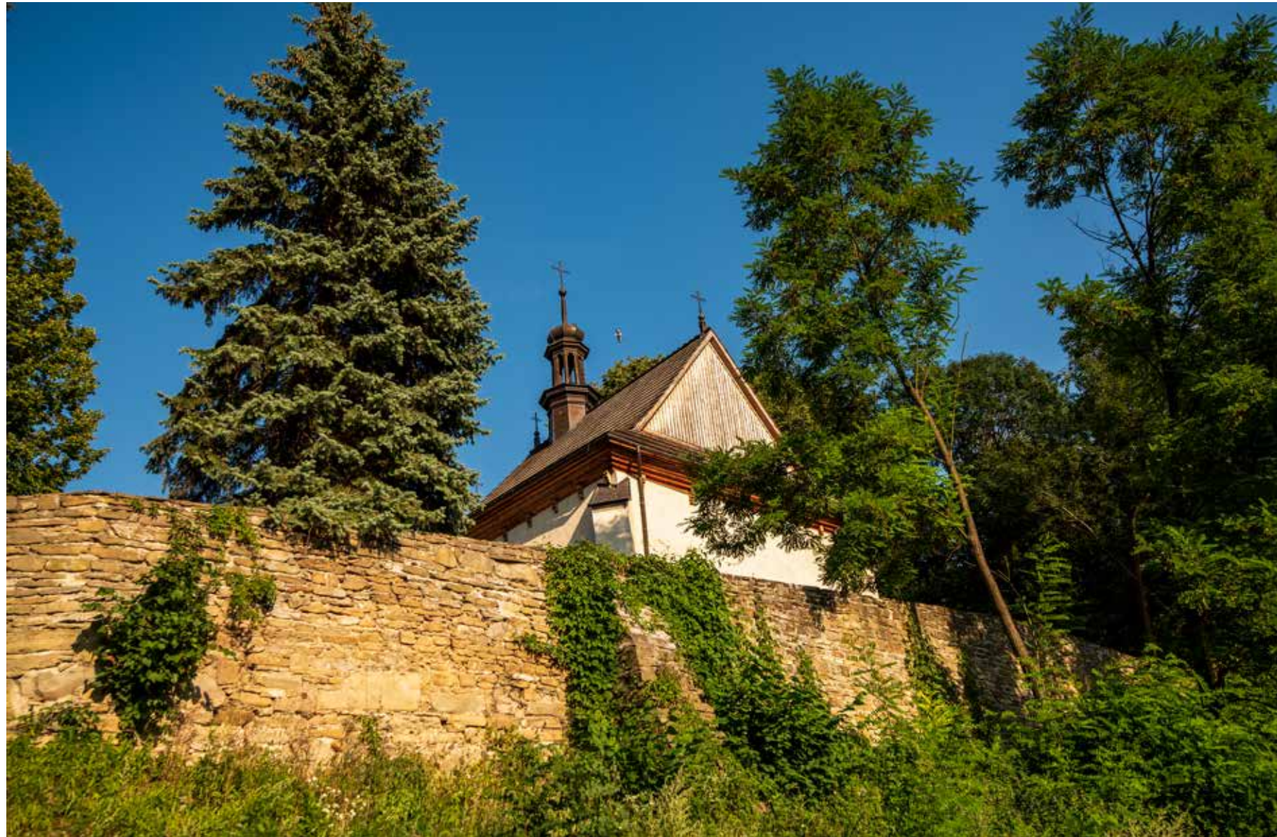
Kościół pw. Św. Bartłomieja, Zbyszyce ↗ Church of St. Bartłomiej, Zbyszyce Kostol Sv. Bartłomiej, Zbyszyce
