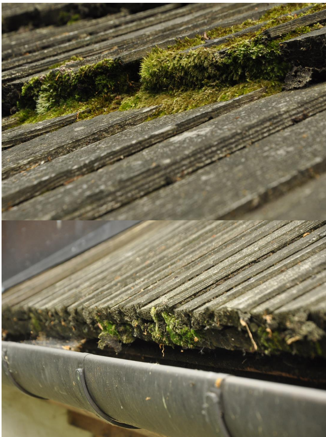
Fot.5-6. Kościół parafialny w Zbyszycach. Stan zachowania pokrycia dachowego ;grudzień 2023 r.
