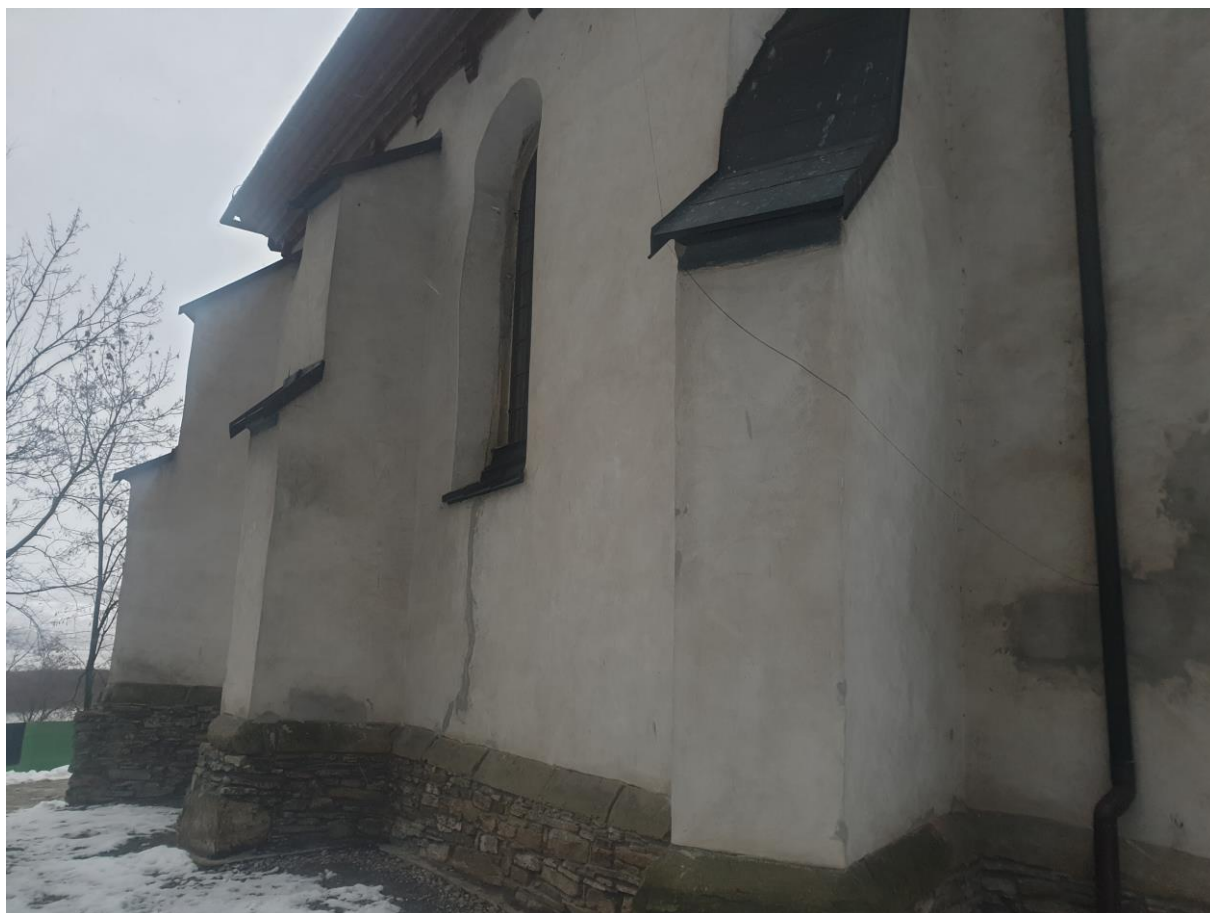
Fot.4. Elewacja południowa kościoła w Zbyszczach.
