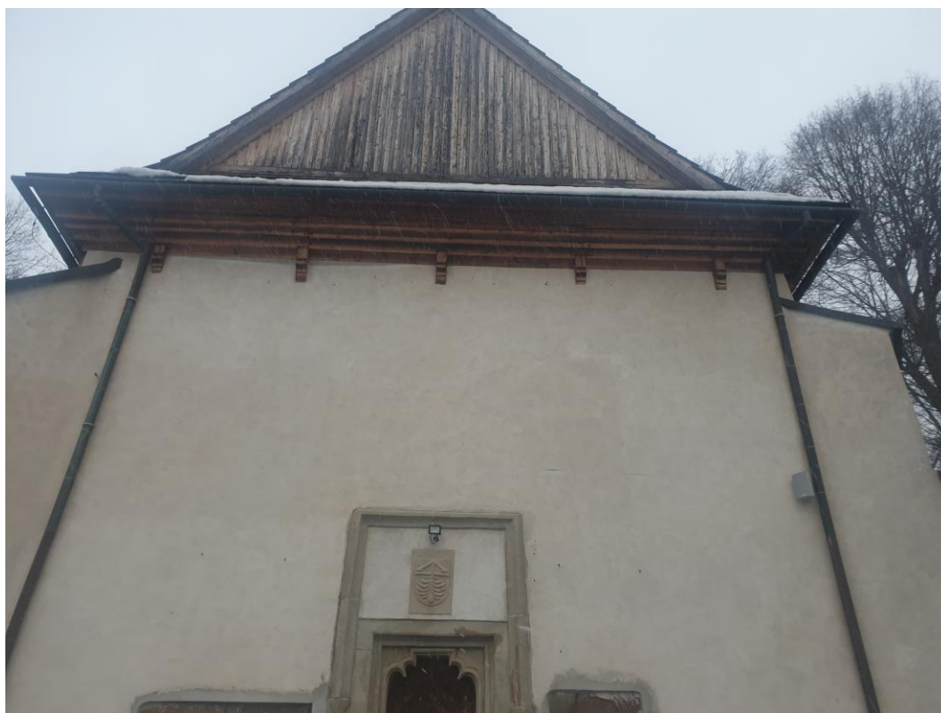
Fot.6. Elewacja zachodnia kościoła w Zbyszczach.
