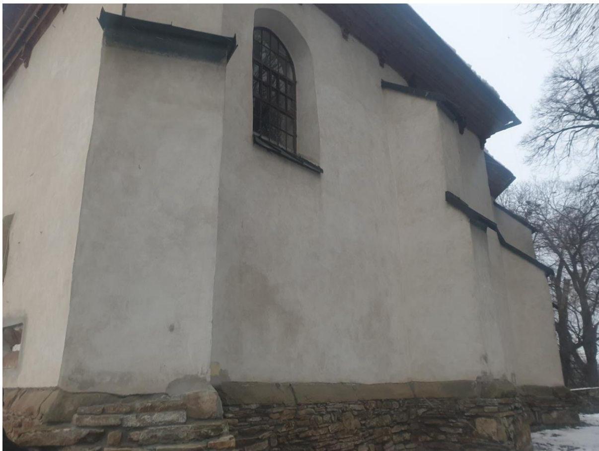
Fot.5. Elewacja południowa kościoła w Zbyszycach.
