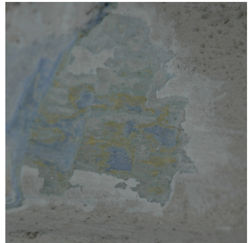
Fot. pobiałe wapienne ściany zewnętrznej oraz gzymsu kolor żółty oraz przeważający kolor ultramaryna
