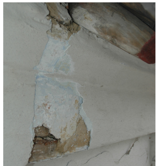
Fot. pobiałe wapienne ściany zewnętrznej oraz gzymsu kolor żółty oraz przeważający kolor ultramaryna
