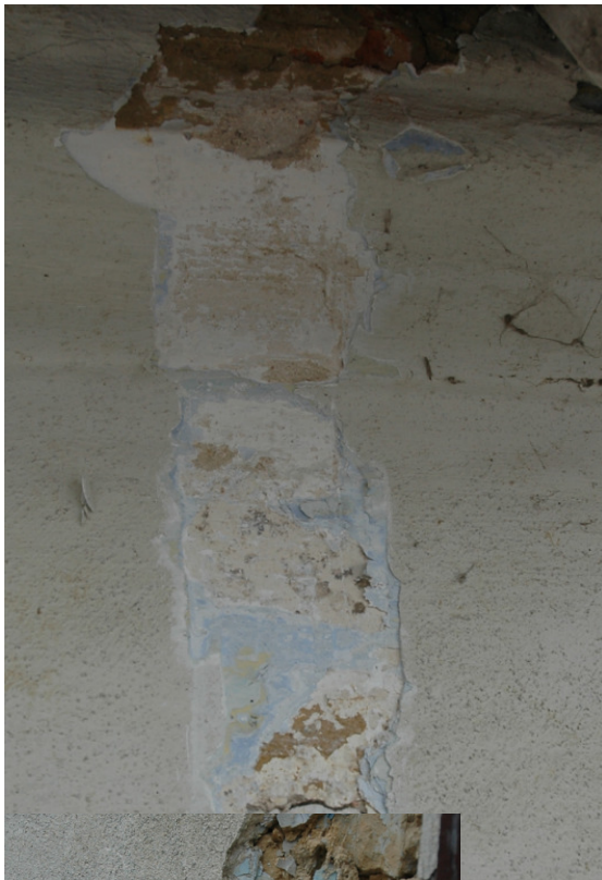
Fot. pobiałe wapienne ściany zewnętrznej oraz gzymsu kolor żółty oraz przeważający kolor ultramaryna
